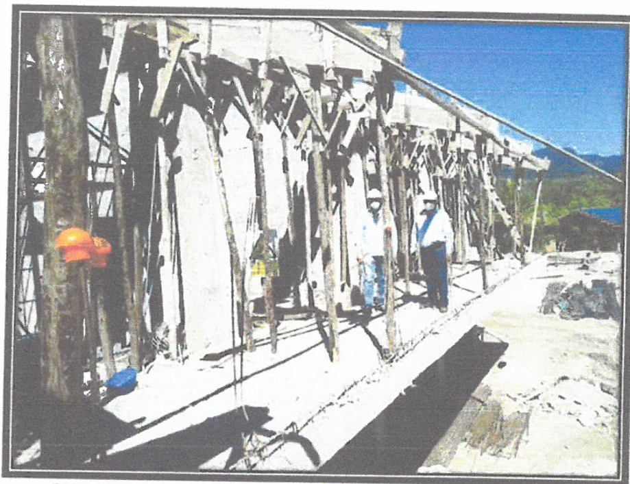
FOTO N°03: Residente y Supervisor verificando trabajos ejecutados en obra.
