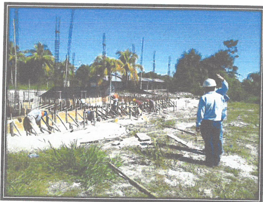
FOTO N°01: Residente y Supervisor verificando trabajos ejecutados en obra .
