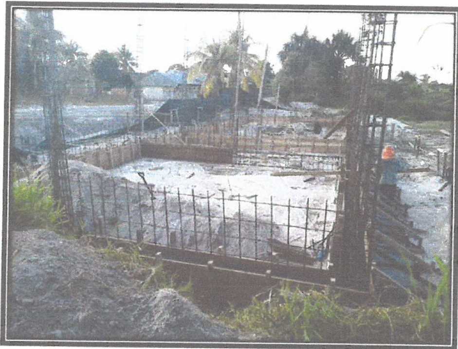
FOTO N°05: ENCOFRADO VIGA DE CIEMENTACIÓN MODULO N°11
