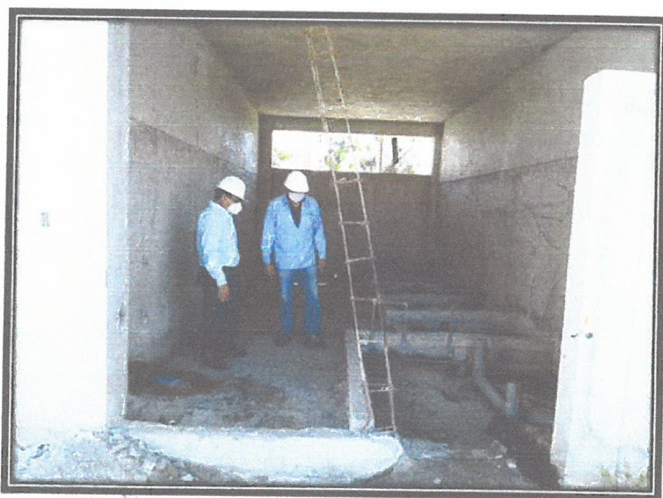
FOTO N°02: Residente y Supervisor verificando trabajos ejecutados en obra.
