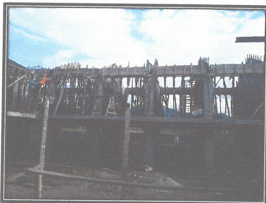
FOTO N°08: ENCOFRADO DE VIGAS MODULO N°01
